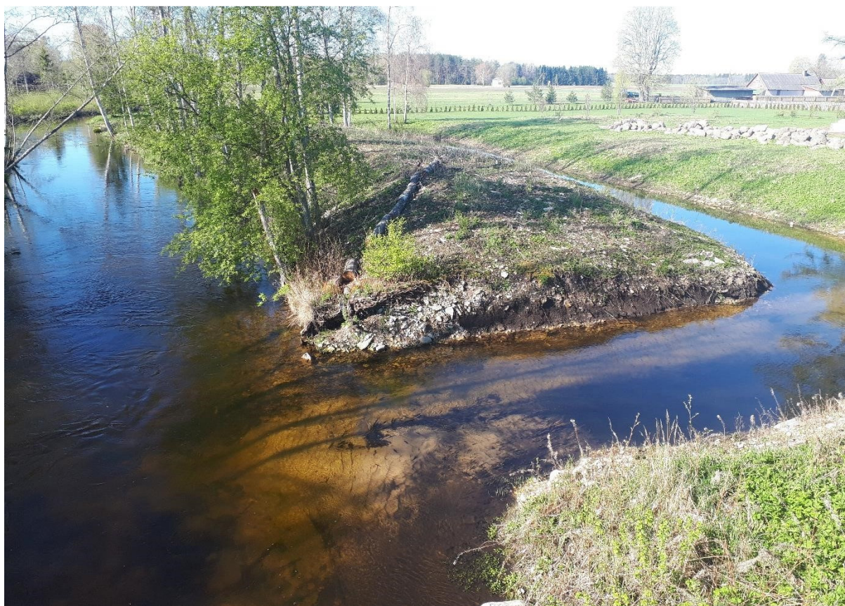
Foto 5. Põltsamaa jõe paremkaldal asuva kanali ülesvoolu asuv ühendus. 06.05.2019
