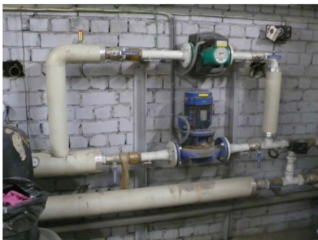
Joonis 2.9 Niidu tn katlamaja biokütuse ladu, kütuse vahepunkter, biokütusekatel koos biokütuse põletiga, vedelkütusekatel, tsirkulatsioonipump ja elektriboiler sooja tarbevee andmiseks lasteaiale (V. Vares'e fotod, 22. dets. 2015)
