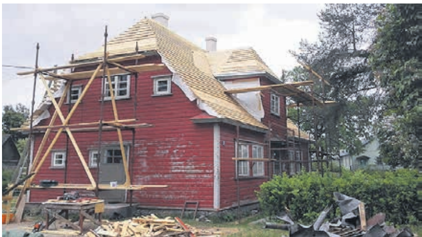
Kotli maja uus katus valmib kohalike ettevõtjate käe all.
