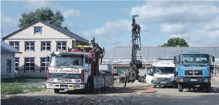
Tervisekeskuse ehitustööd algasid aukude puurimisega maaküttesüsteemi jaoks.
