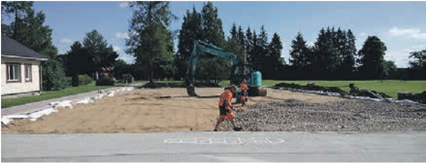
Multifunktsionaalse pallimänguväljaku ehitustööd Simunas.
