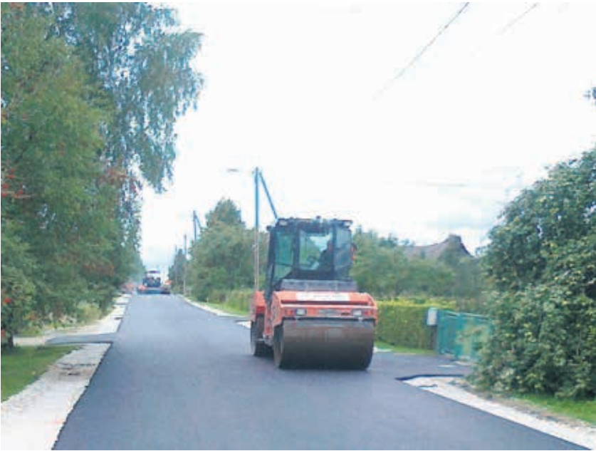
Käimas on asfalteerimistööd Väike-Maarjas Energia tänaval. Foto: Kaarel Moisa
