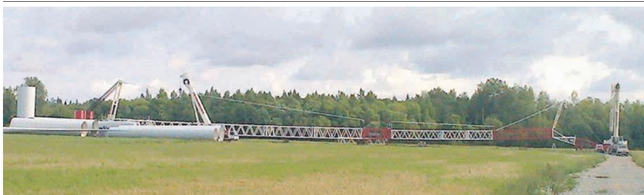
Aburisse rajatava tuulegeneraatori püstitamiseks on vaja eritehnikat. Pildil tuulegeneraatori tõstmiseks tellitud spetsiaalne tõstekraana, mis peab hakkama saama nii 105 m torni ehitamisega kui ka 80 m diameetriga tiiviku paigaldamisega. Foto: Alan Senkel, 12.08.14
