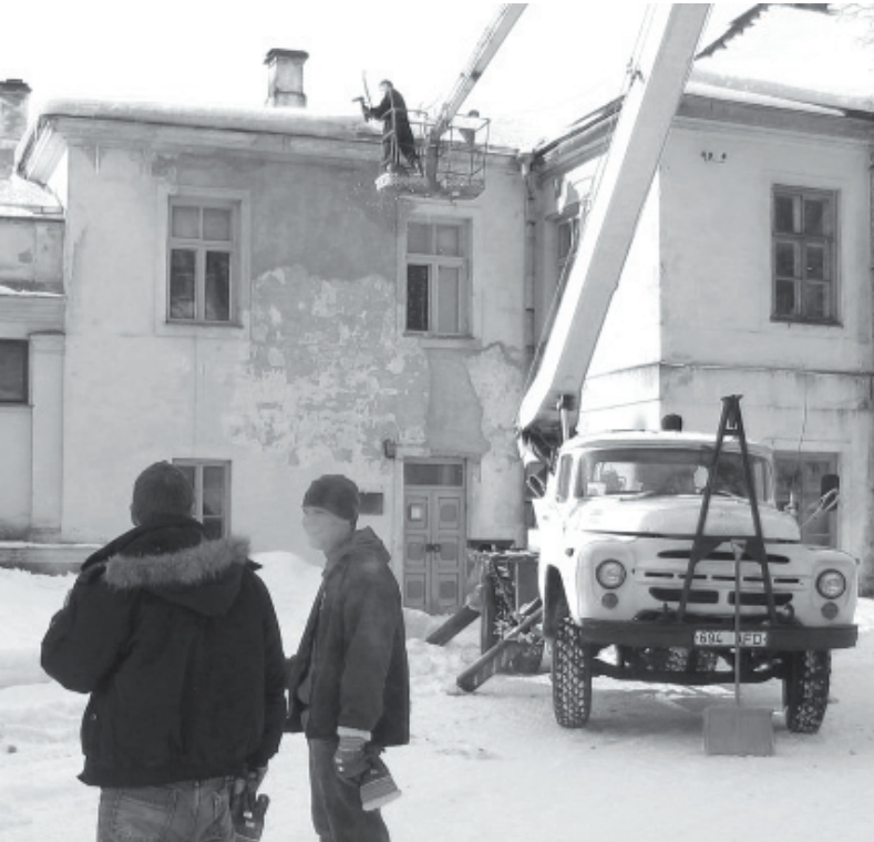
Eelisel lumerohkel talvel Avanduse mõisa katust päästmas. Foto: Marju Metsmann
