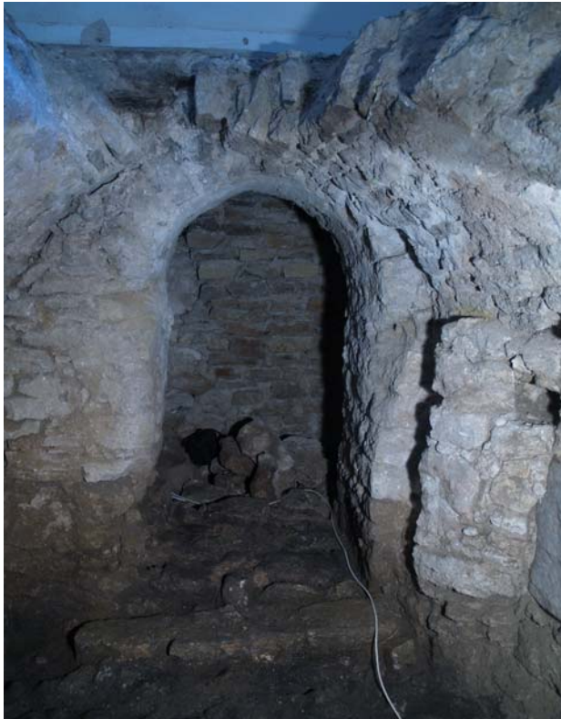
PILDIL: Keskaegne uks praeguse koolipõranda all. Ukse ees on säilinud saviga seotud aste ning munakivisillutis. Ukse kohal on näha kunagist võlvi, mille keskosa on kokku varisenud.
