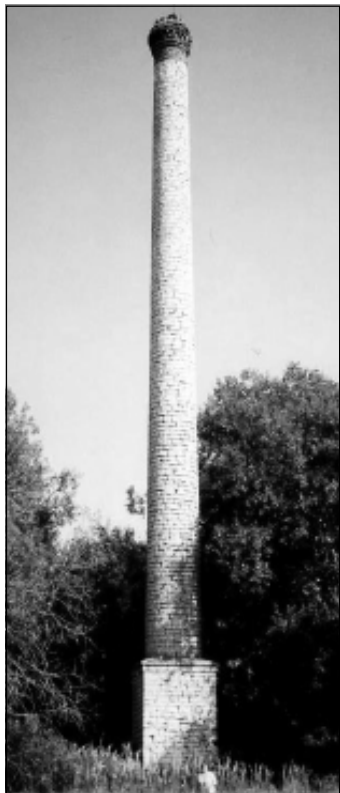
Antu mõisa viinavabriku korsten
