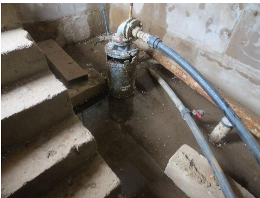
Joonis 5-13 Kaarma puurkaevpumpla sisevaade, puurkaevu päisehitis, põrandal on ligikaudu 10 cm vett
