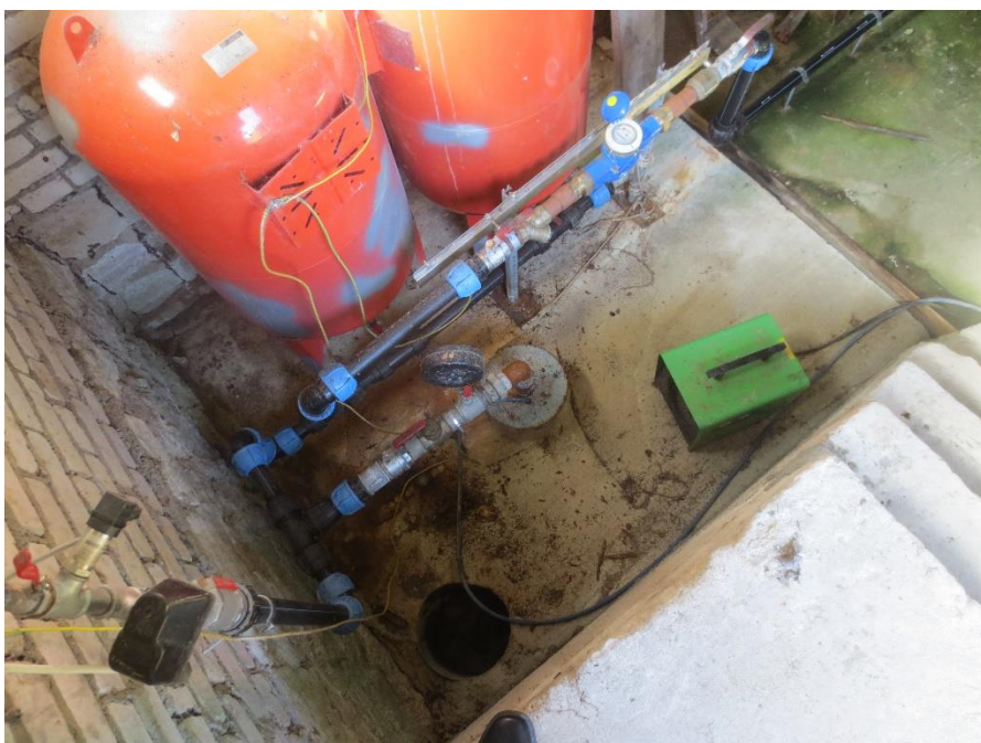
Joonis 5-37 Salla pk sisevaade (2x500 l hüdrofoorid, pk päis ja kalorifeer sooja tagamiseks)
