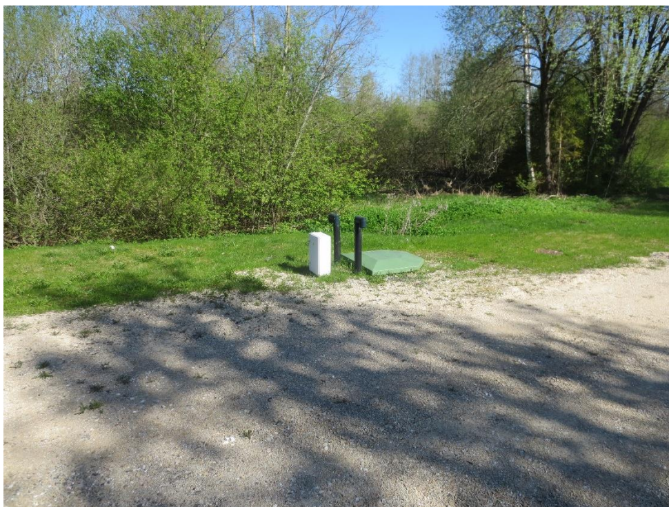
Joonis 6-12 Kase ehk peapumpla on rekonstrueeritud ÜF Projekti: Rakke valla ühisveevärgi ja kanalisatsioonisüsteemide rekonstrueerimine, raames
