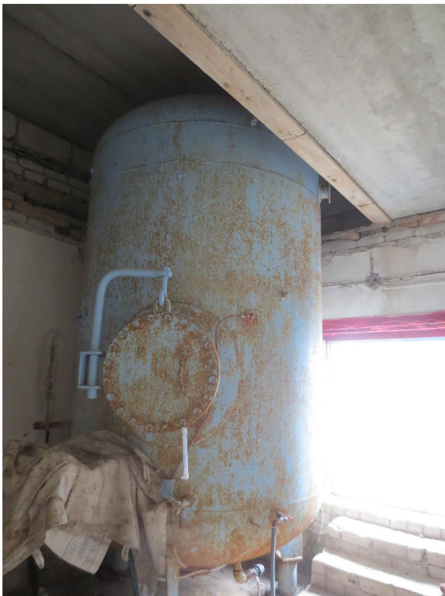
Joonis 5-3 EPT puurkaevpumpla 5 m 3 hüdrofoor
