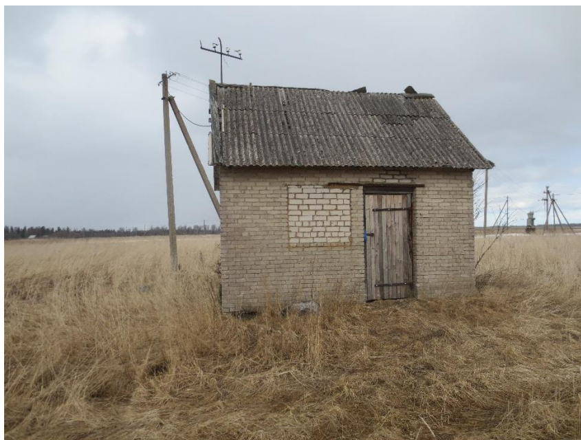
Joonis 5-38 Aburi puurkaevpumpla välisvaade
