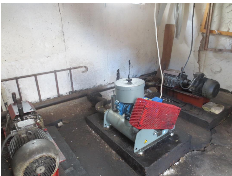
Joonis 6-19 Keskel puhurite ruumi töötav puhur
