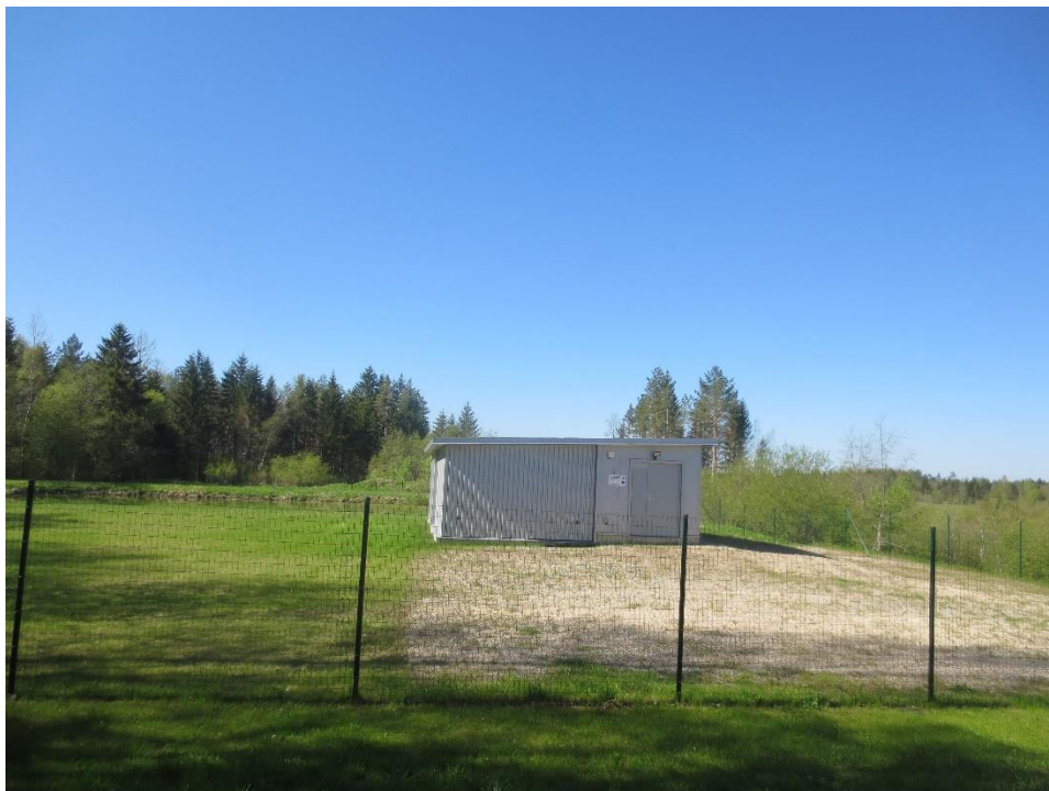
Joonis 6-14 Rakke reoveepuhasti välisvaade, tehnohoone
