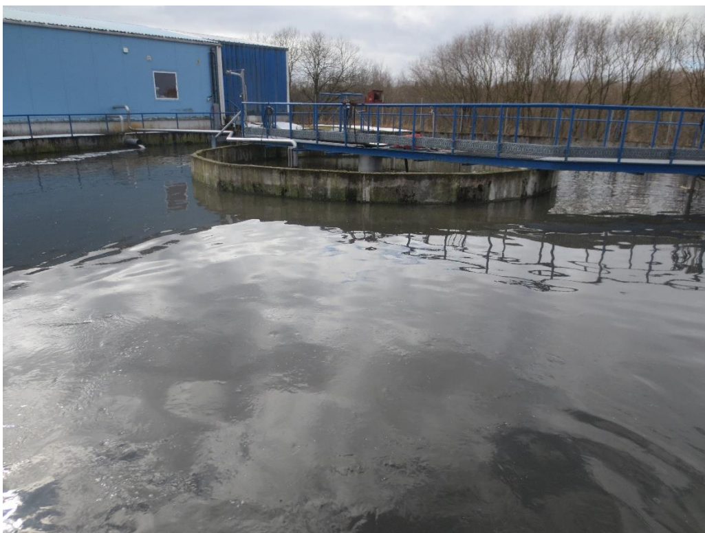
Joonis 6-7 Vana MRP-1000 tanki kasutatakse ühtlustusmahutina (foto 06.04.2018, mil liigvee kogus oli väga intensiivne)
