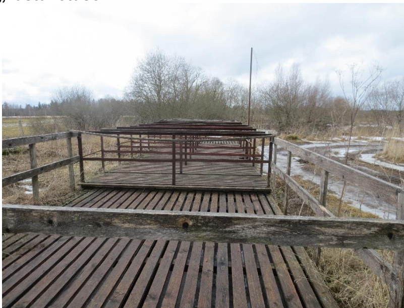
Joonis 6-23 Endine, praegu reovee kogumismahtina kasutusel olev BIO-100 reoveepuhasti
