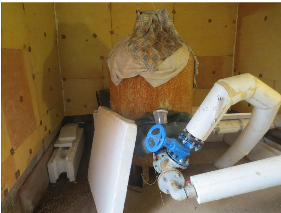
Joonis 5-9 Piirituse pumplahoone sisevaade, osa torustikest on soojustatud. Näha 1 m 3 -ne hüdrofoor
