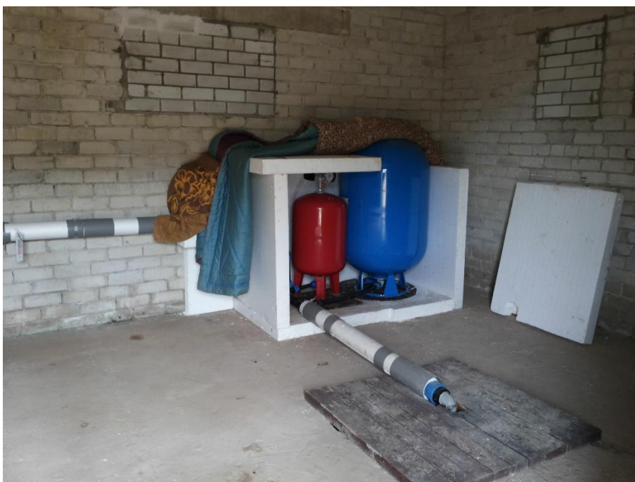
Joonis 5-35 Vao pk sisevaade, hüdrofoorid, puurkaevu päisehitis
