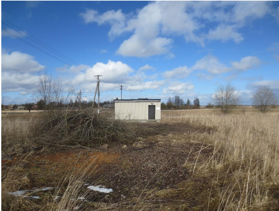
Joonis 5-23 Simuna keskuse pk pumpla välisvaade
