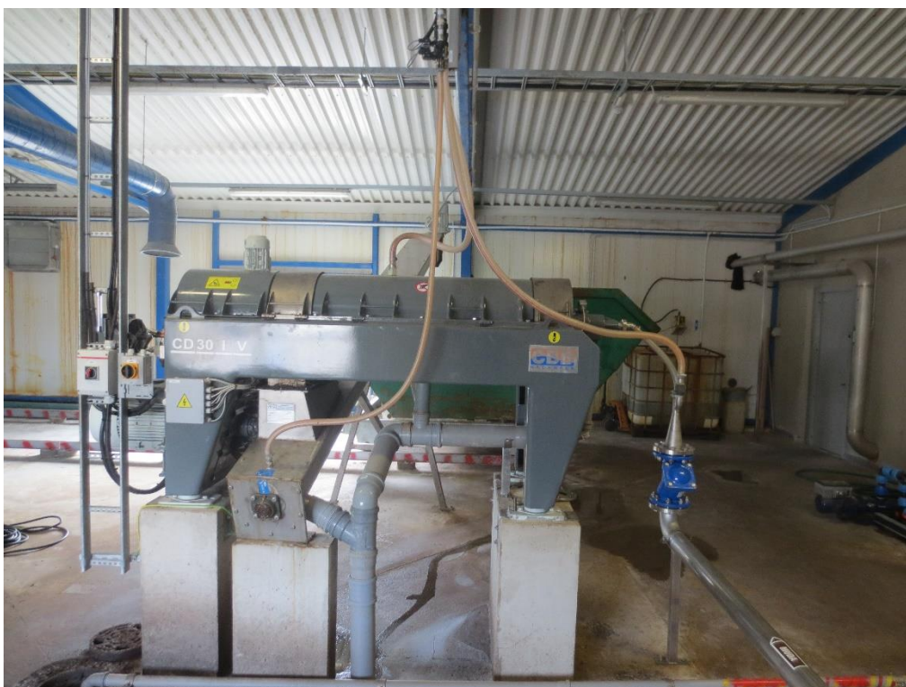
Joonis 6-8 Mudatahenduseks kasutatakse tsentrifuugi
