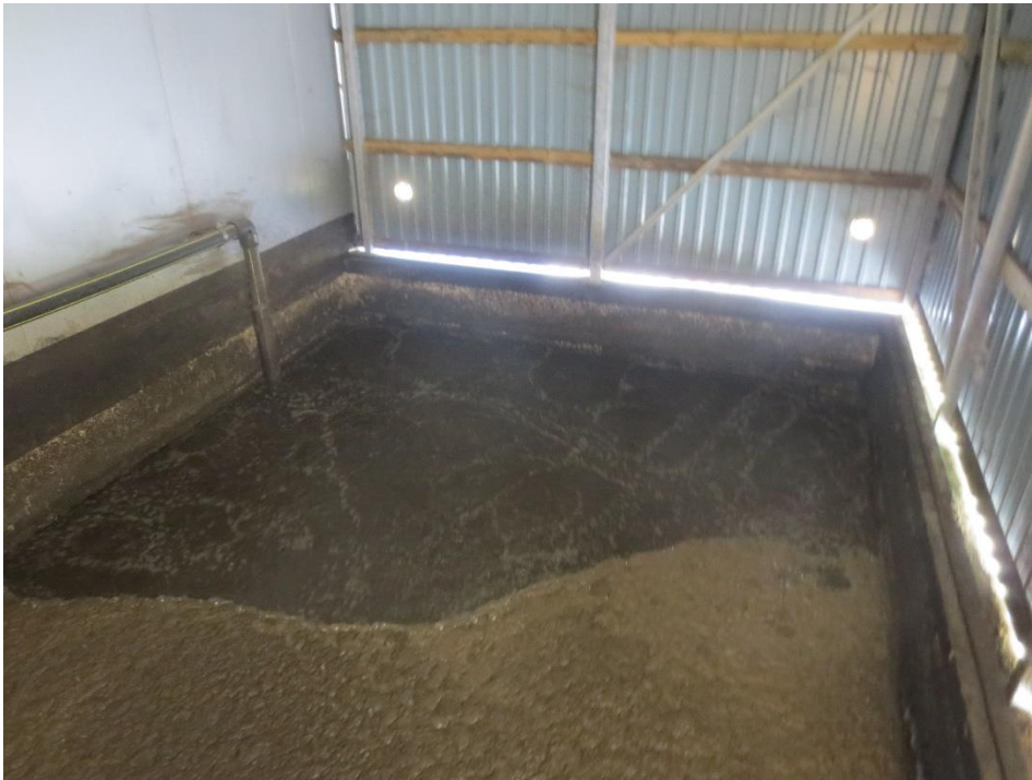
Joonis 6-16 Aerotank paikneb hoone külmas ruumis
