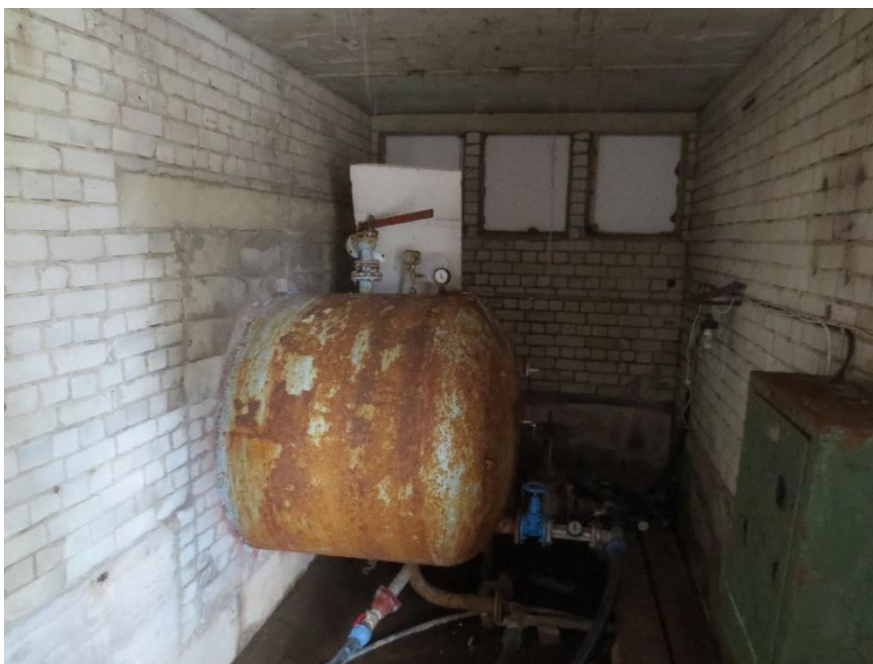
Joonis 5-12 Kaarma puurkaevpumpla sisevaade, nähtaval hüdrofoori hoonesse jääv osa
