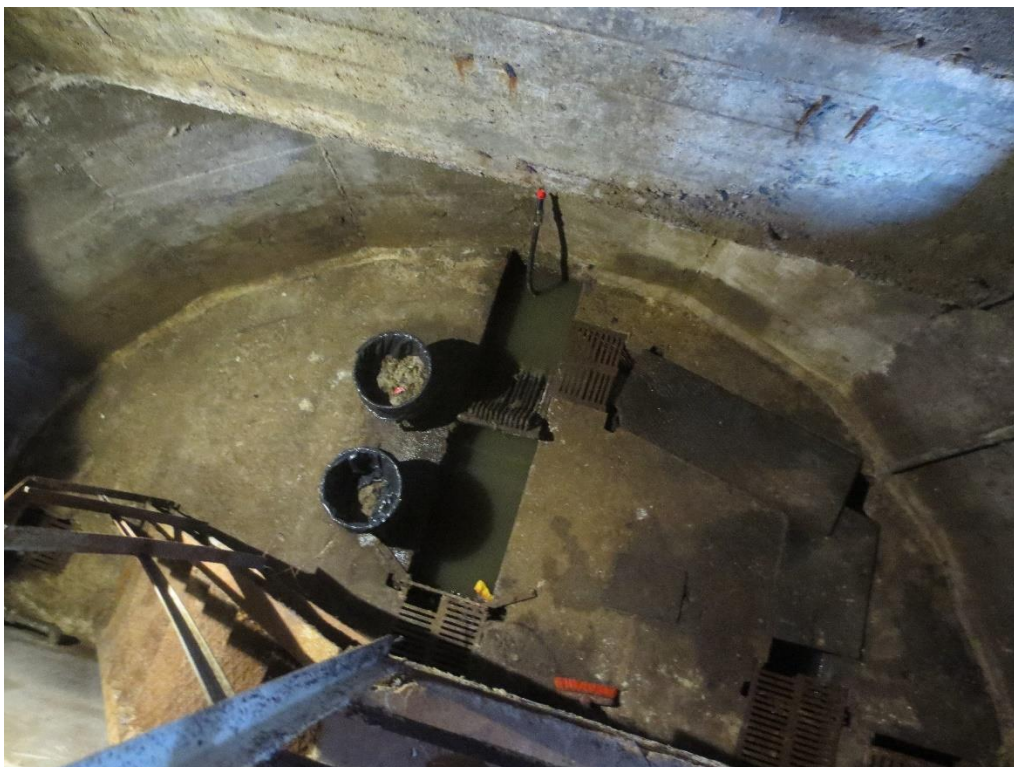
Joonis 6-2 Pumpla käsivõre
