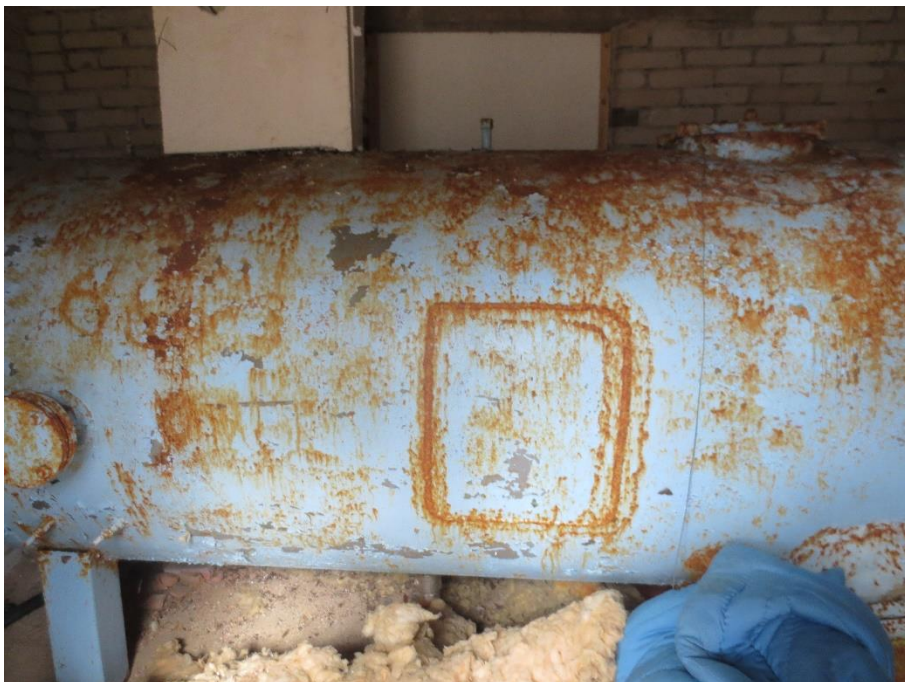
Joonis 5-27 Kilti mõisa pk sisevaade, hüdrofoor
