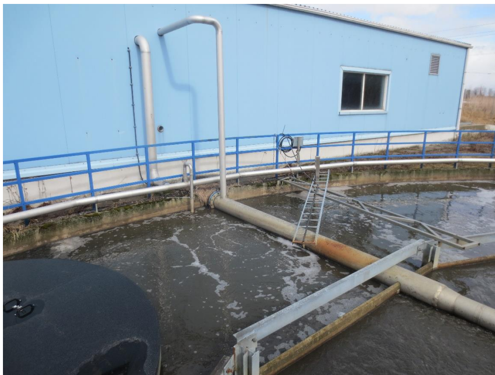
Joonis 6-6 Väike-Maarja reoveepuhasti välisvaade, aerotank, vasakul on näha fragment järelsetitist
