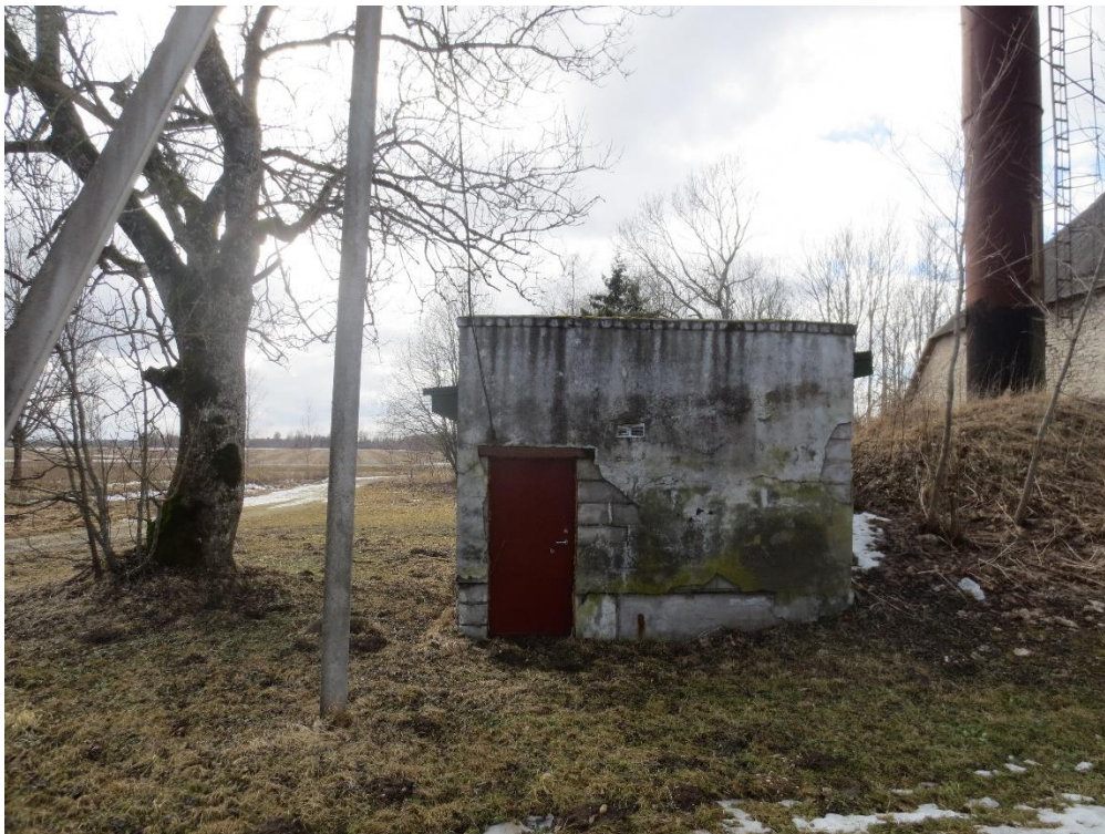
Joonis 5-31 Triigi pargi pumppla välisvaade, hoone seisund on mitterahuldav
