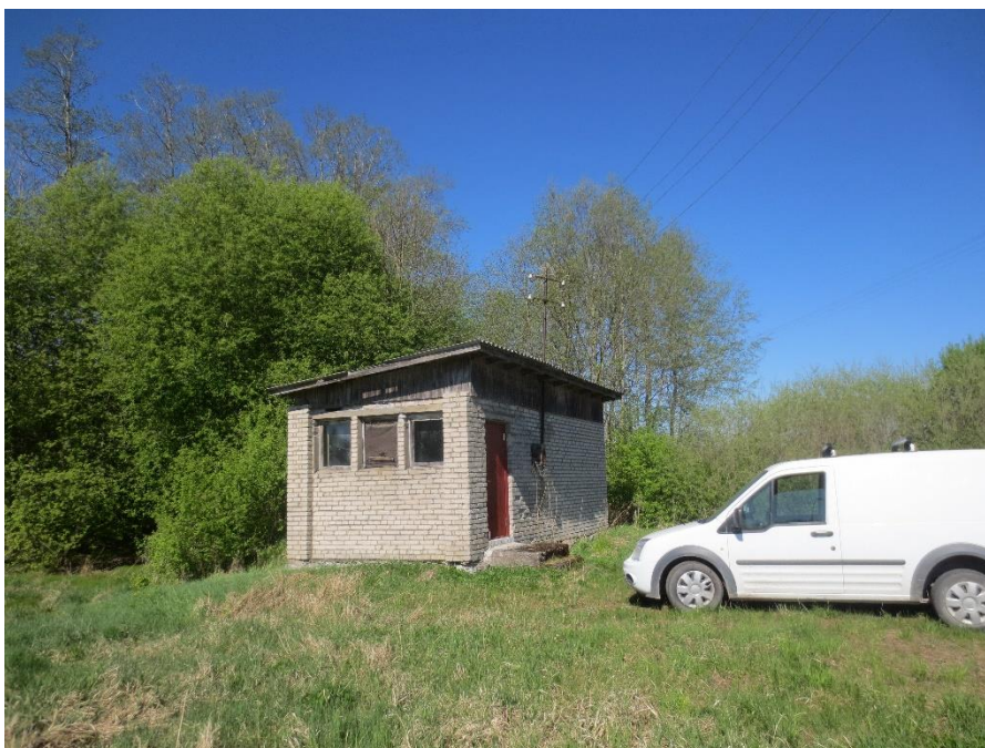
Joonis 5-36 Salla puurkaevpumpla välisvaade
