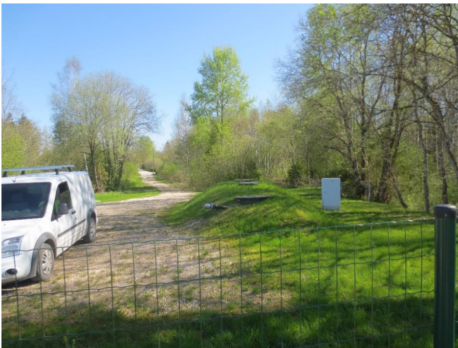
Joonis 6-17 Rakke purgimissõlm (vastuvõtusõlm on kõrgel ja loodusliku pinnast ei kaitse võimaliku üle- või möödavoolu reostuse eest miski)
