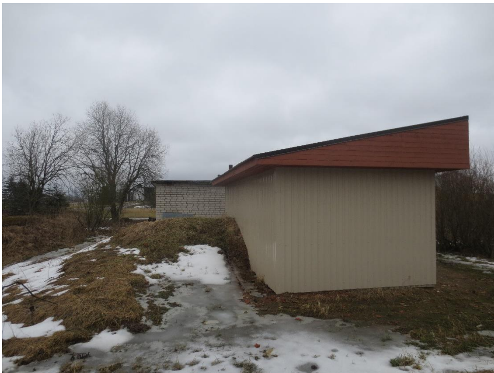
Joonis 5-11 Kaarma puurkaevpumpla välisvaade, esiplaanil renoveeritud puurkaevpumpla, tagaplaanil silikaattellistest vana II-astme pumpla, mis on kasutusest väljas. Hoonest väljas olev muldkeha katab 5 m 3 hüdrofoori
