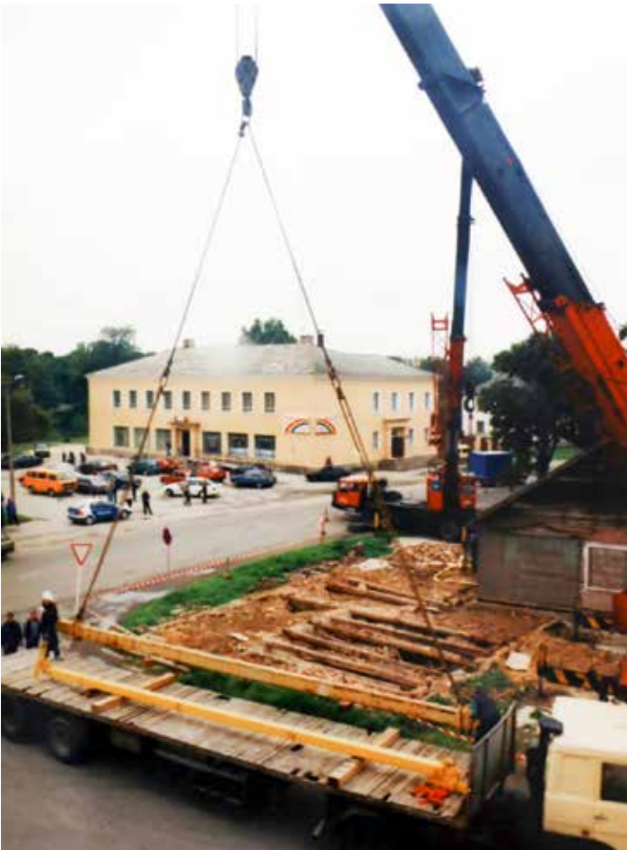
7. septembril 2001 tuli teelaiendusele ette jääv tsaariaegse maja kahe kraanaga üles tõsta ja kogu täiega uuele vundamendile panna. Foto: Avo Pardi erakogust
