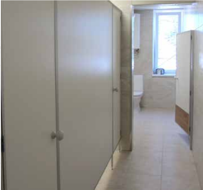
Tammiku hooldekodu ruumide remont. Foto: Heli Aade
