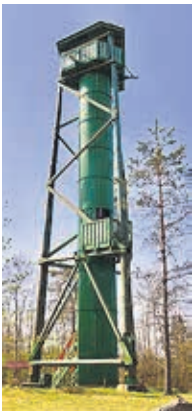
Emumäe torn. Foto Signe Sabas
