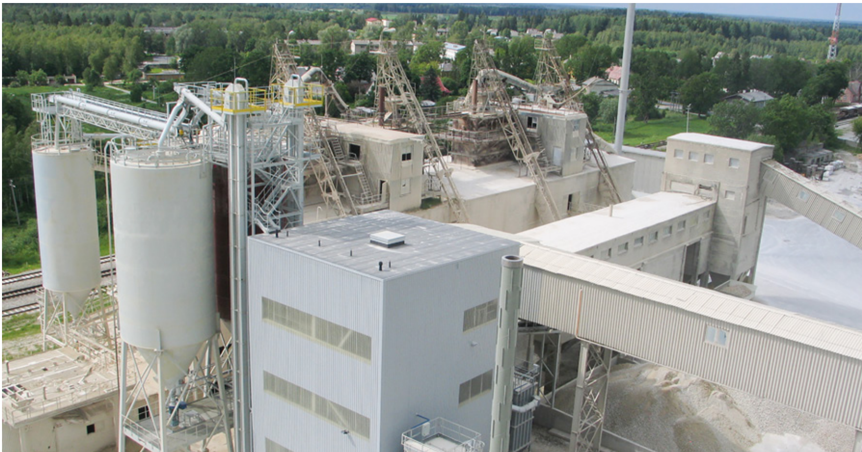
AS-i Nordkalk Rakke tehas. Foto: Nordkalk
