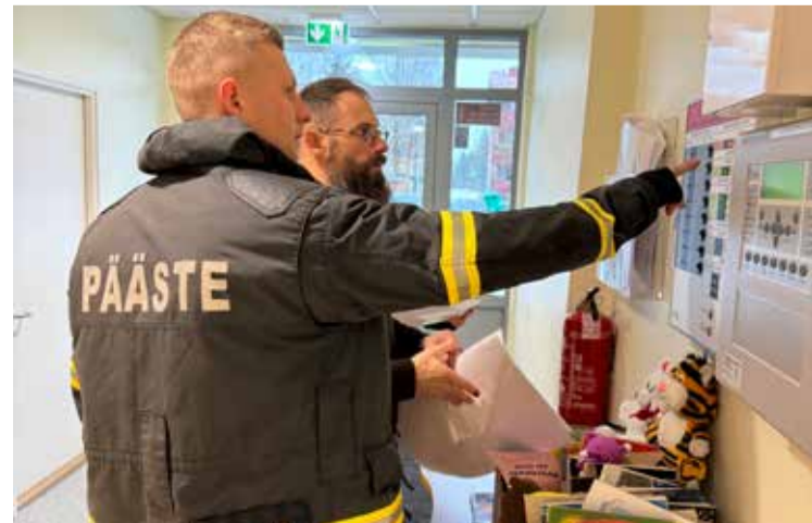
Päästjad pöörasid tähelepanu evakuaatsiooni tingimustele, häiresüsteemide korrasolekule ja tulekustutusvahendite olemasolule. Foto: Jana Kroll
